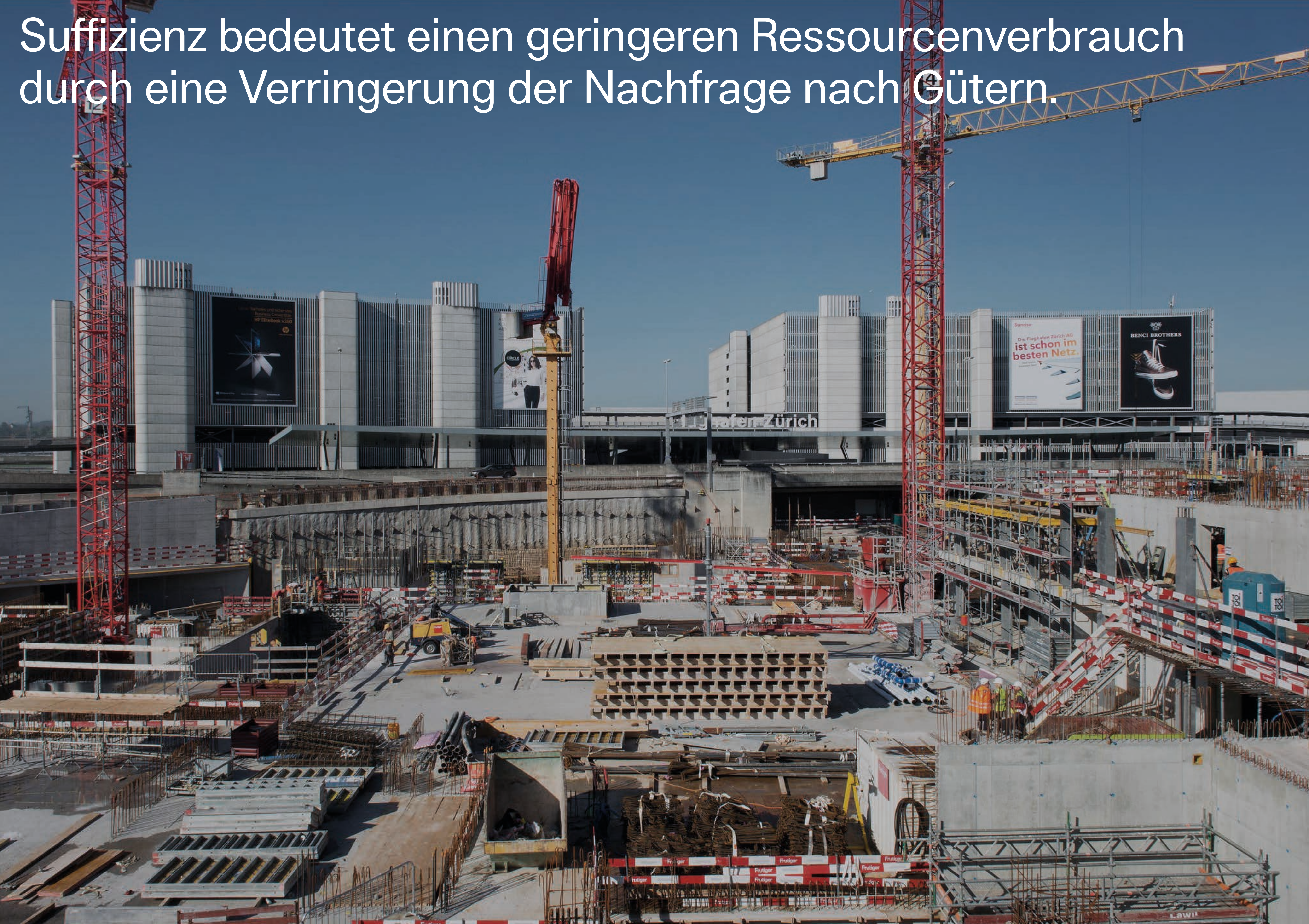
Baustelle The Circle, Flughafen Zürich, Foto: Karin Hofer, 2017
